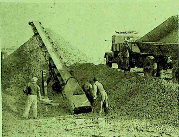
Nel cantiere si riprende a lavorare
